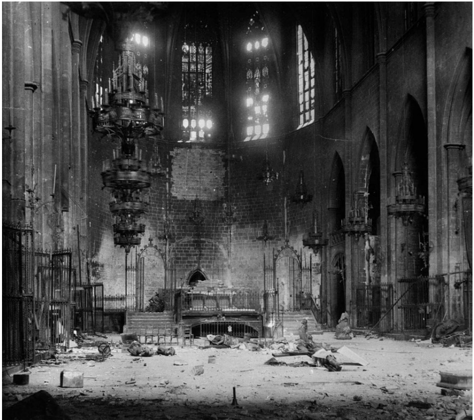
Fig. 1: Interior de l'església de Santa Maria del Pi (Barcelona) després de la devastació del 1936. Foto: Institut Amatller d'Art Hispànic. Arxiu Mas.
